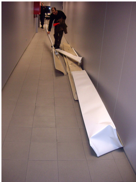
foto 1. panells d'alumini retirats. Total 5 panells
