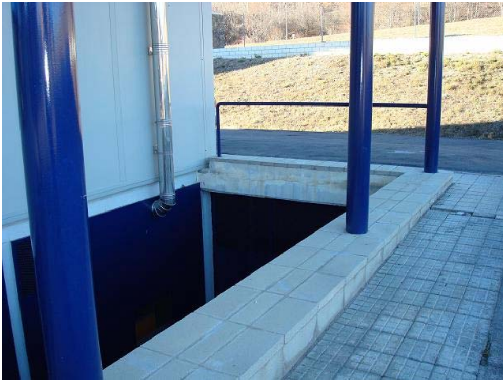
ABP PUIGCERDÀ. Desnivell sense protecció.
