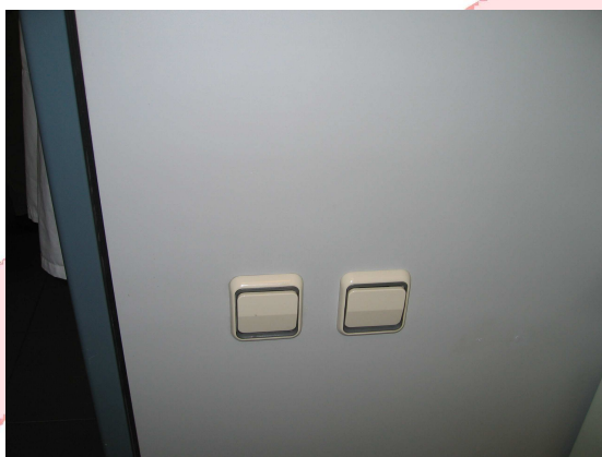
Les parets no són ignífugues
