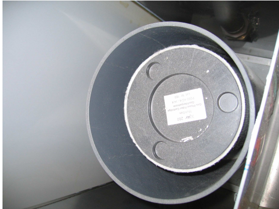
Filtre del forn de revelatge
