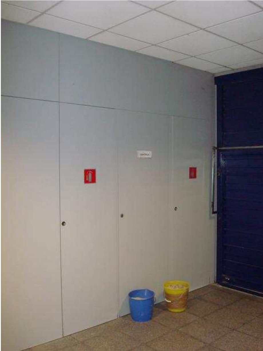
Foto 1. Zona garjoles. Els sistemes contraincendis estan a l'interior de les dependències.
