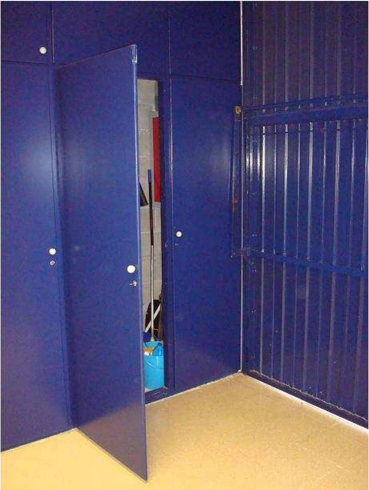
Foto 1. Extintors i BIE ubicats en una dependència expressa a la zona garjoles. La porta de la dreta està bloquejada a causa del mecanisme de la porta del pàrquing.
