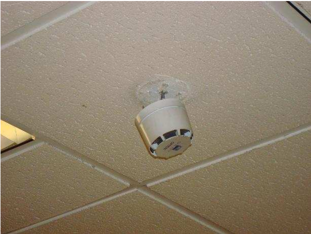
Foto 2. Detector de fums després del sostre a la zona garjoles.
