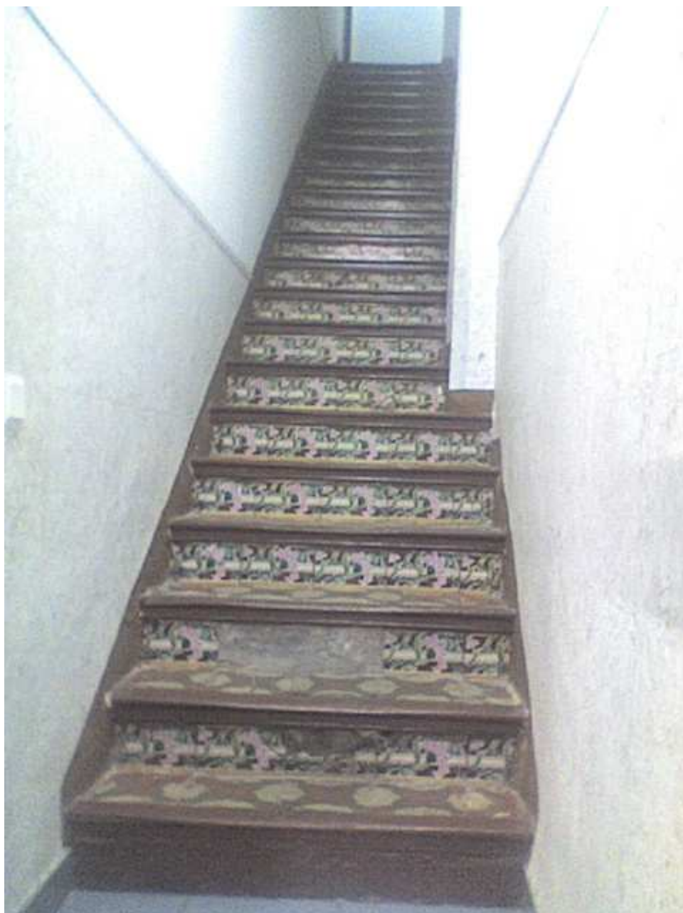
Foto. Escala d'accés als vestuaris de l'ABP d'Amposta (23 esglaons)
