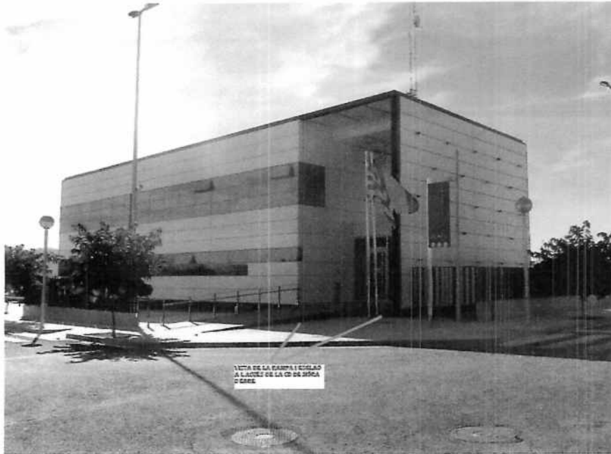
Foto 1. Façana principal de la CD Mora d'Ebre
