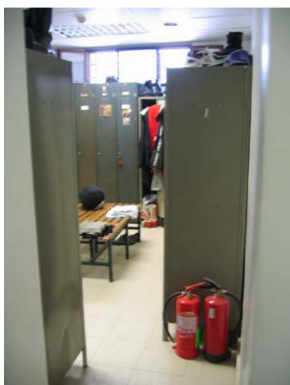
Foto 3. Extintors a terra (a tot el cos de guàrdia).
