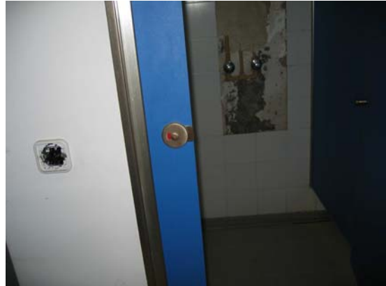
Foto 10 i 11. Taquilles petites, interruptor trencat i reparacions aturades.
