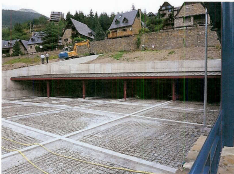
Pavimentació del nou pàrquing exterior.
