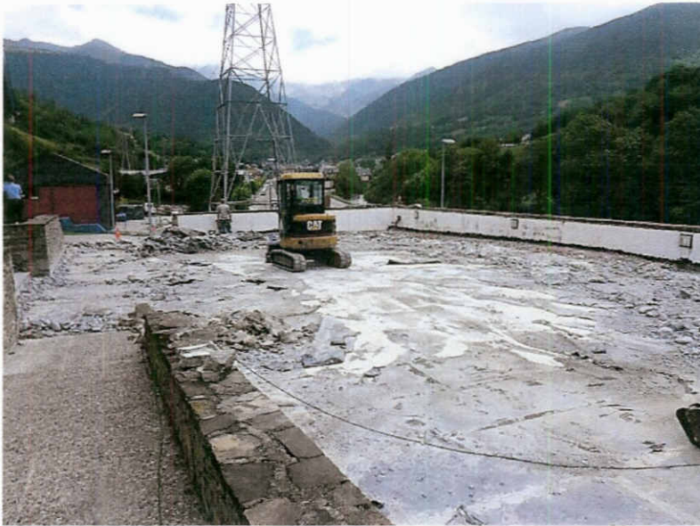
Canvi del paviment de l'actual pàrquing exterior.
