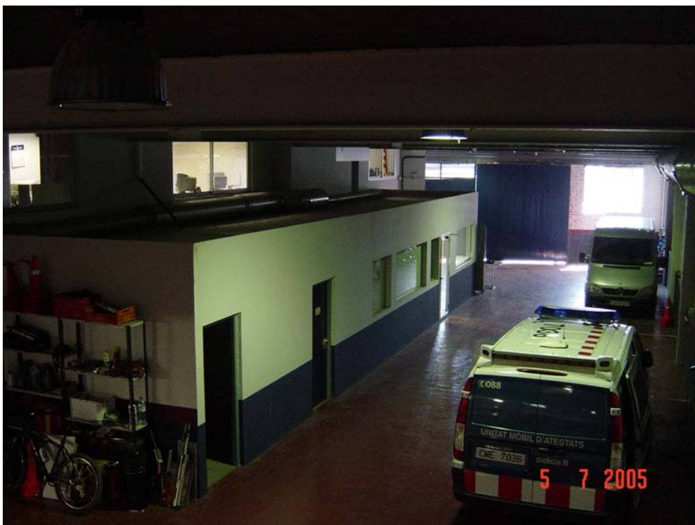
Dependències sense llum natural ni ventilació a l'exterior i amb barreres arquitectòniques.
