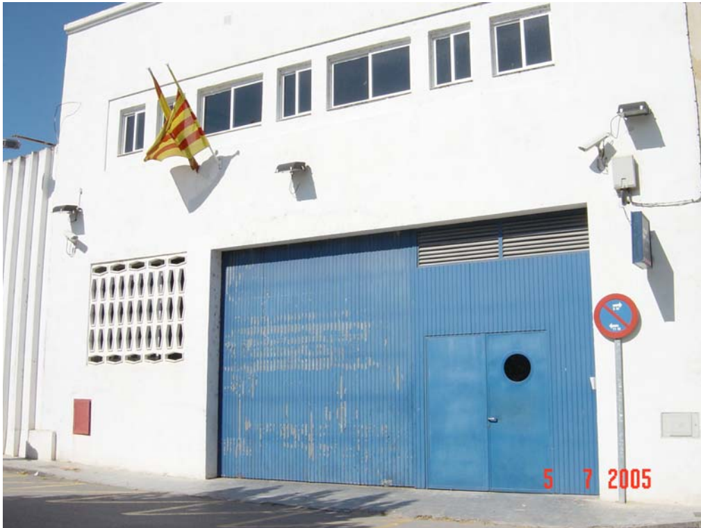
Entrada principal de comissaria inadequada.
