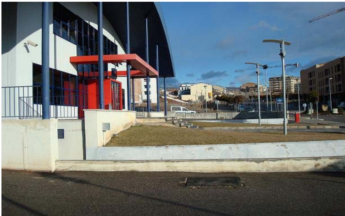
ABP TREMP. Desnivells originats per la rampa del pàrquing.
