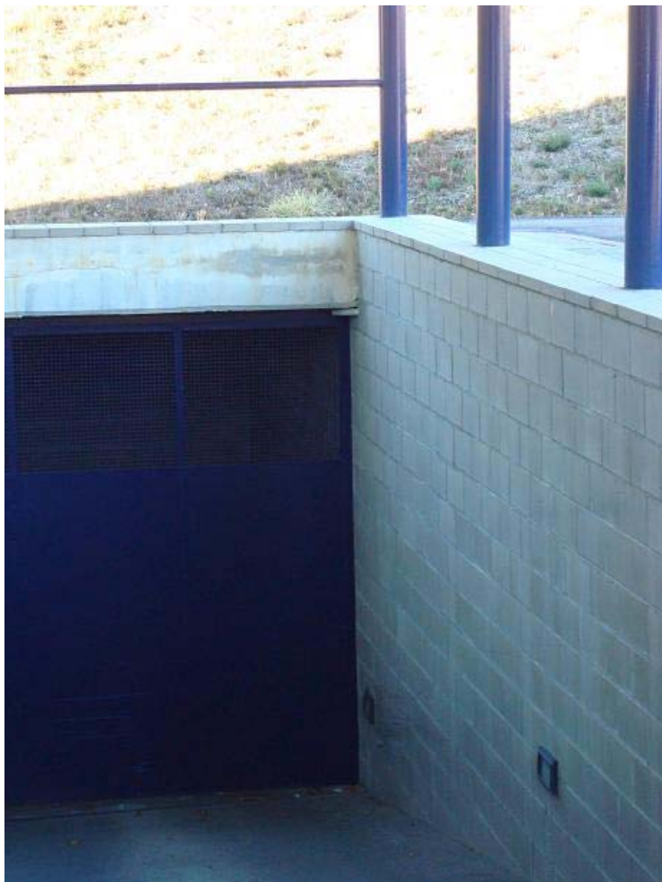
ABP PUIGCERDÀ. Rampa pàrquing i màxim desnivell.
