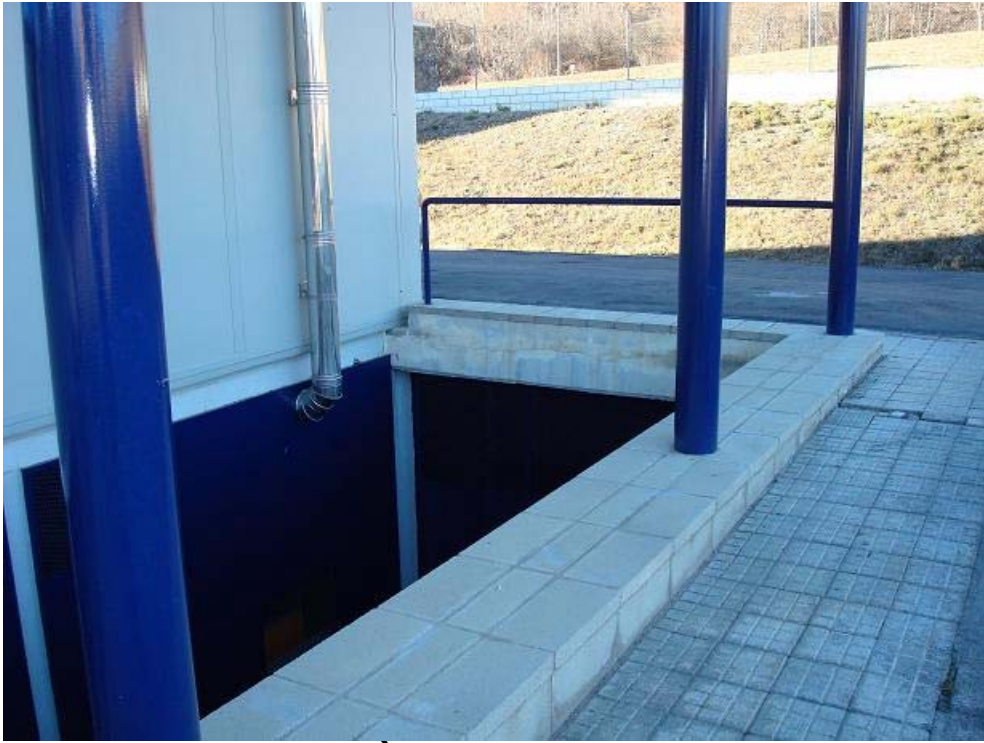
ABP PUIGCERDÀ. Desnivell sense protecció.
